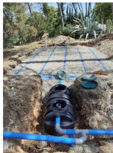
Figure 17- ANC avant recouvrement
