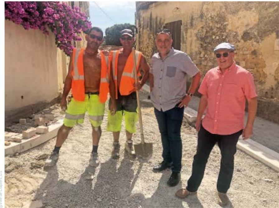
Tout au long de l'été le chantier a bien avancé, grâce au travail des entreprises partenaires du projet et leurs ouvriers : les connexions au réseau des eaux usées ont été reprises, les voiries anciennes et abîmées du centre ancien en ont laissé place à un béton à granulats calcaires et de basalte. Le long des rues, des pavés en pierre calcaire et de belles bordures ont pris racine.
