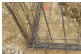
Nœud de chaînage - Continuité mécanique
